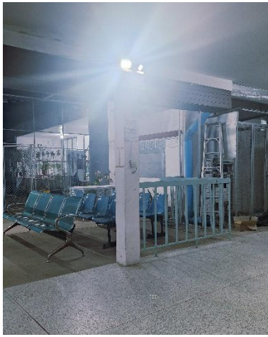
ติดตั้งโคมไฟแสงสว่างฉุกเฉิน ทางสัญจร
