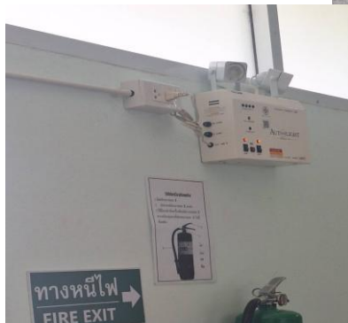
ติดตั้งโคมไฟแสงสว่างฉุกเฉิน บันไดทางหนีไฟ
