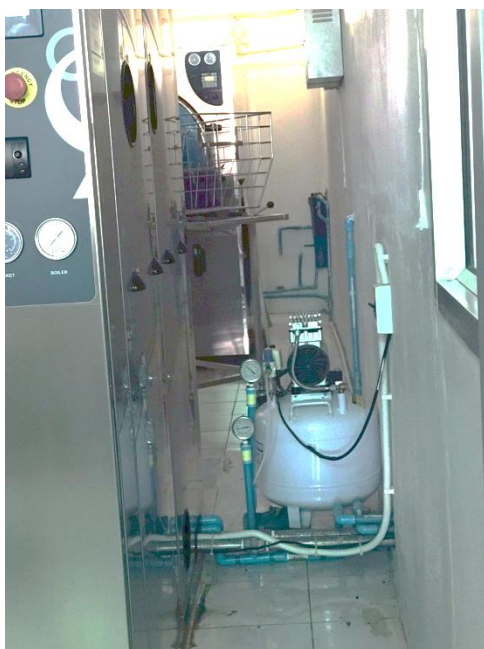
ภาพ เครื่องนึ่งอุปกรณ์ทางการแพทย์หน่วยจ่ายกลางสำหรับส่งน้ำเข้าและระบายน้ำออก
