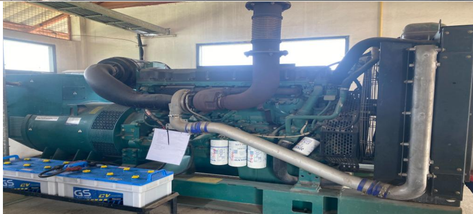
ระบบสำรองไฟกล้องวงจรปิด
